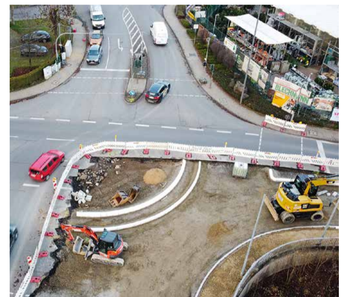
Scheibchenweise wird der neue Kreisverkehr am Hagebaumarkt Blechmann entstehen, das verhindert lange Staus und Umleitungen.
